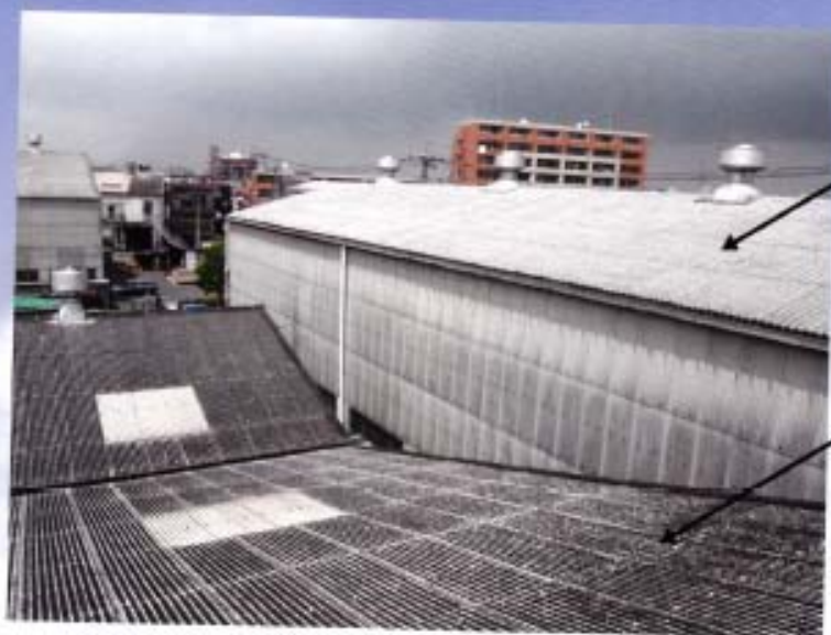
スレート屋根補強・防水施行例
